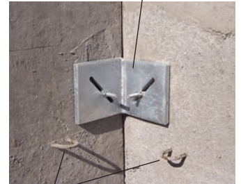
Mise en œuvre des éléments de soutènement
