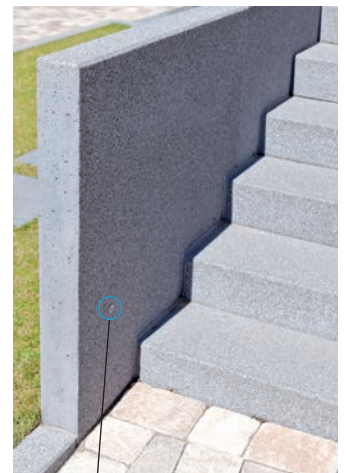
Anses de transport recouvertes de capuchons gris en PVC
